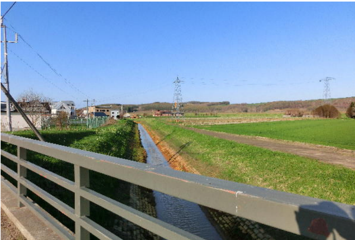
* 橋の上から排水機場の方を見て
