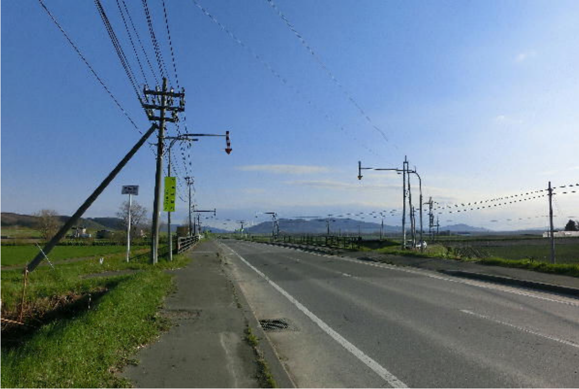
* 道道北見常呂線の常呂市街側から見た橋の正面
