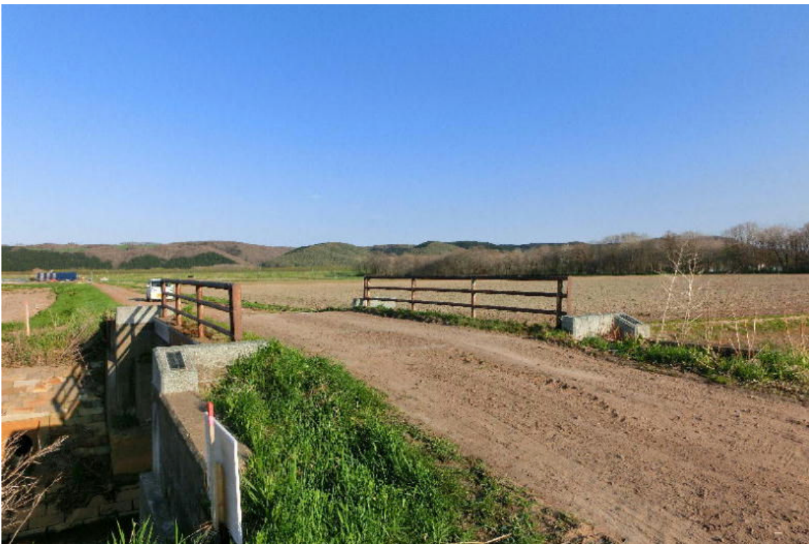
* 西1線側から道道側の橋の正面を見て
