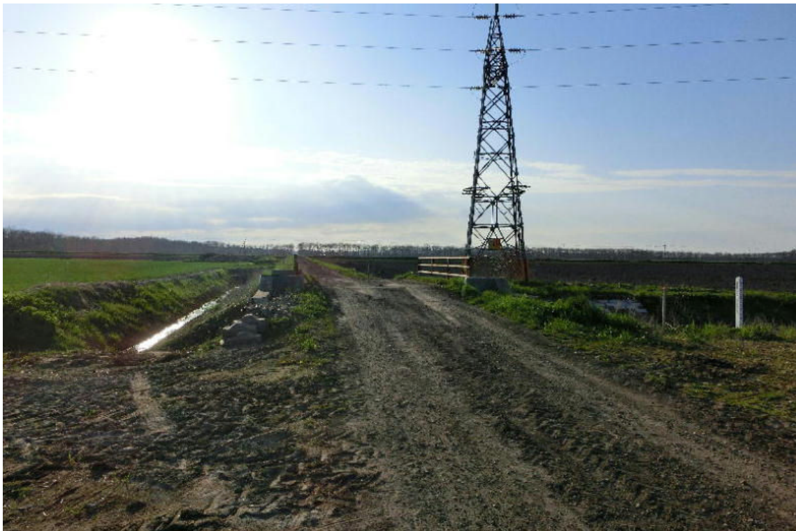
* 道道の7号道路標識側から見た橋の正面
