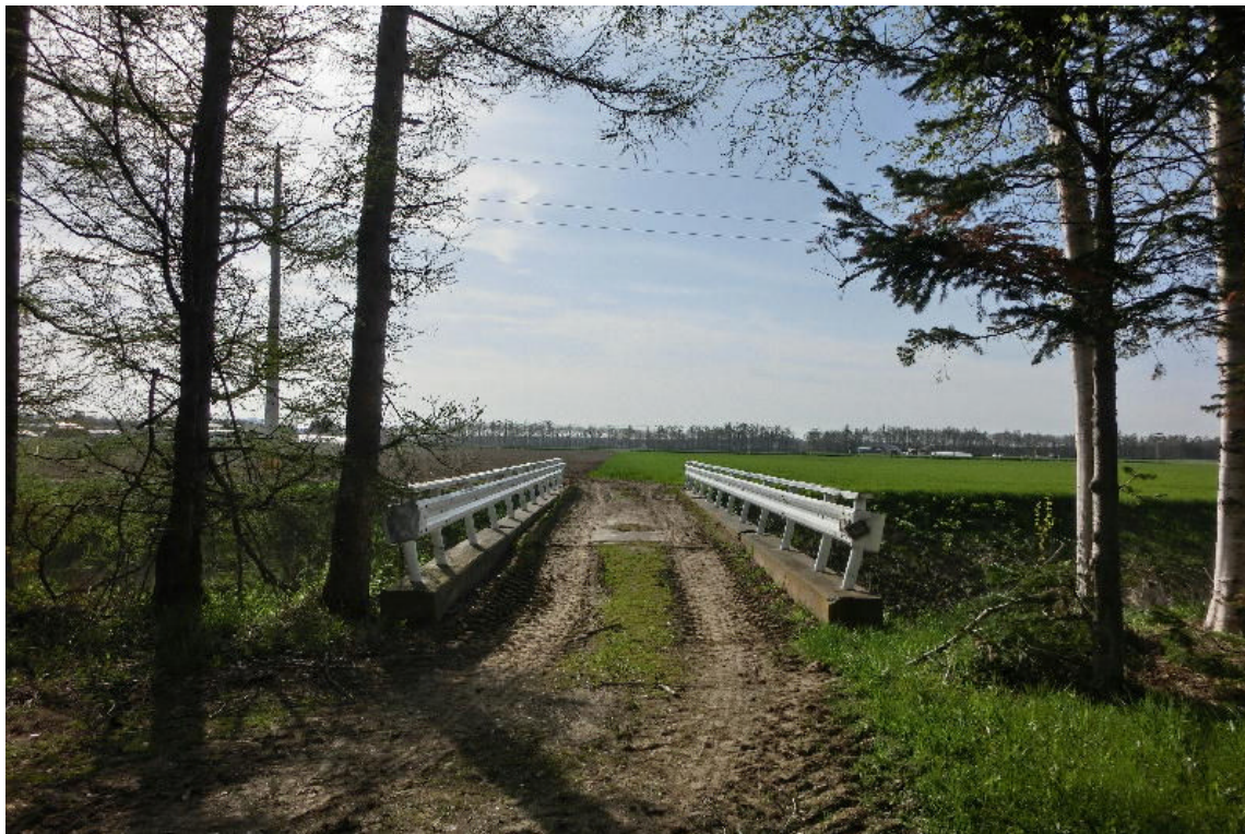
* 共立八幡神社の境内から橋の正面を見て
