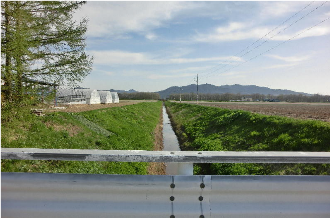
* 橋の上から10号道路方面を見て（奥に第1幹線10号橋）
