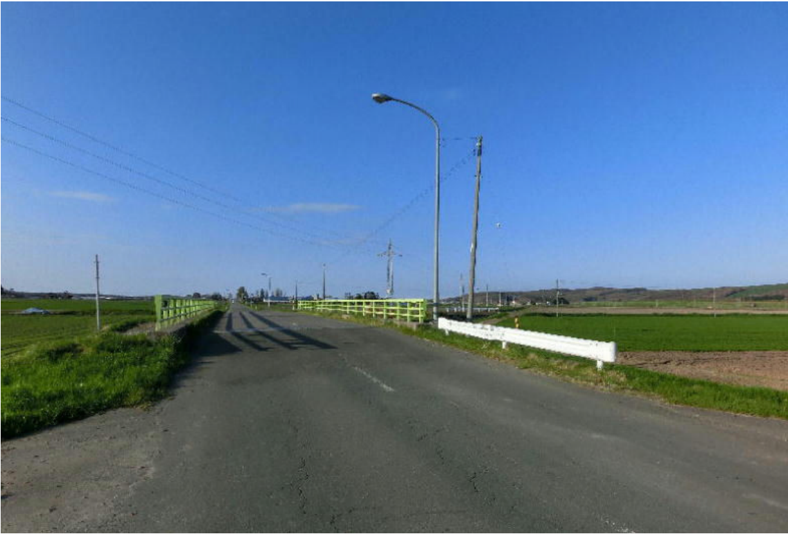
* 7号側から見た橋の正面：奥が常呂方面
