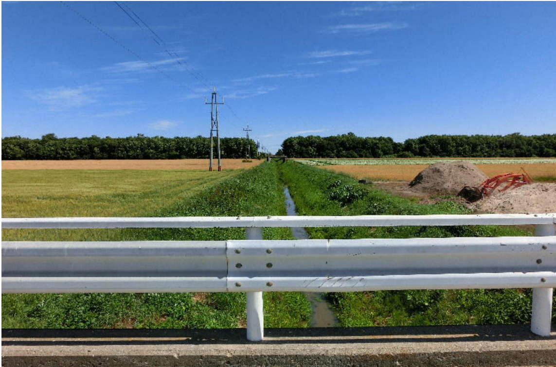
* 橋の上から常呂方面を見て（奥に旧湧網線の跨線橋あり）
