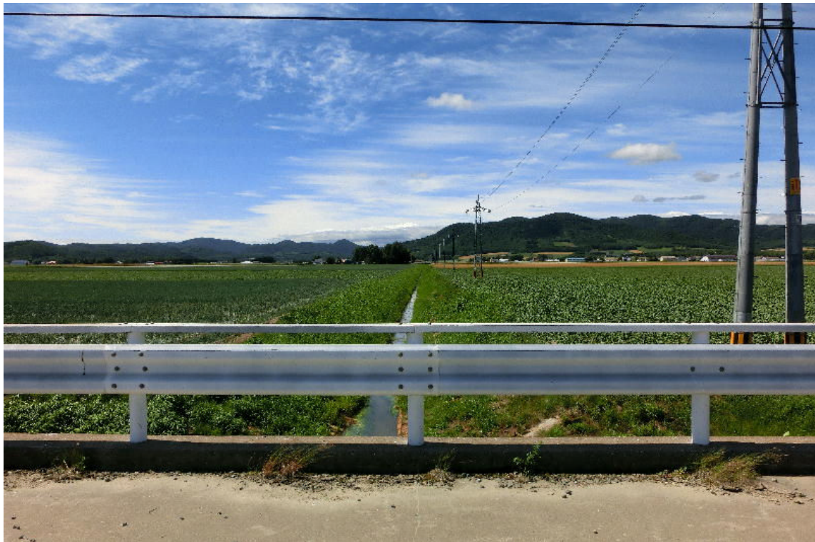
* 橋の上から12号道路方面を見て
