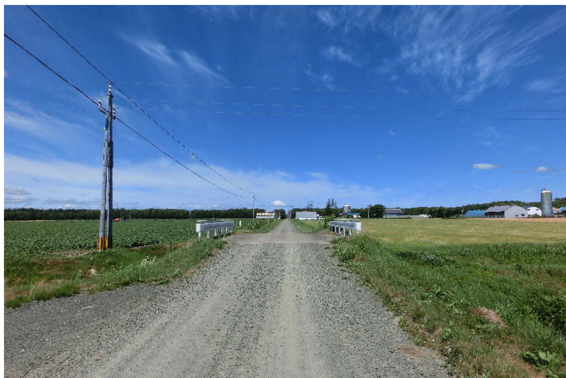
* 基線側から見た橋の正面
