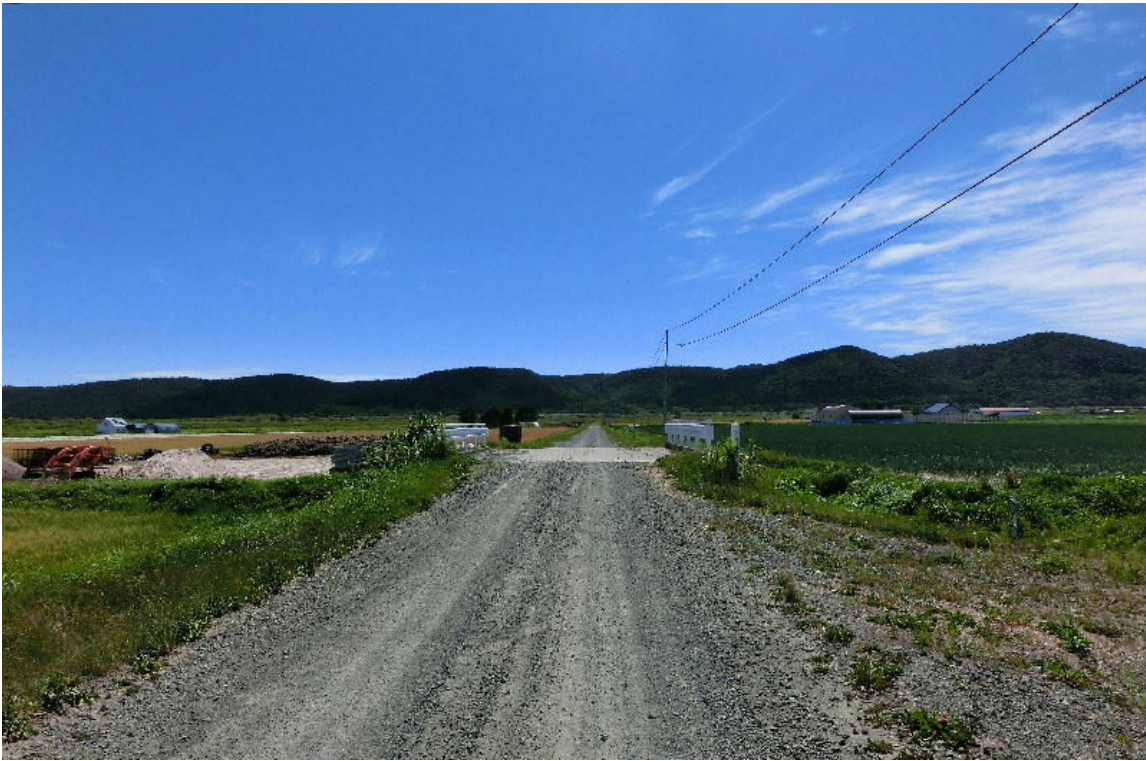
* 西 1 線側から橋の正面を見て
