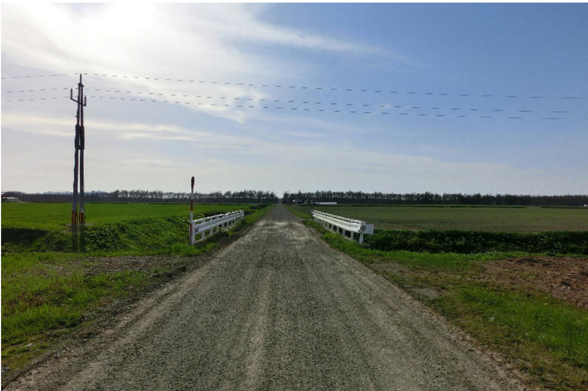
* 道道の9号道路標識側から見た橋の正面
