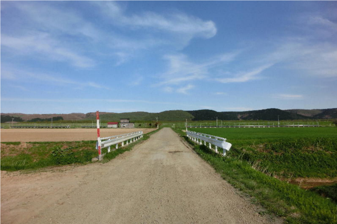
* 西 1 線側から橋の正面を見て
