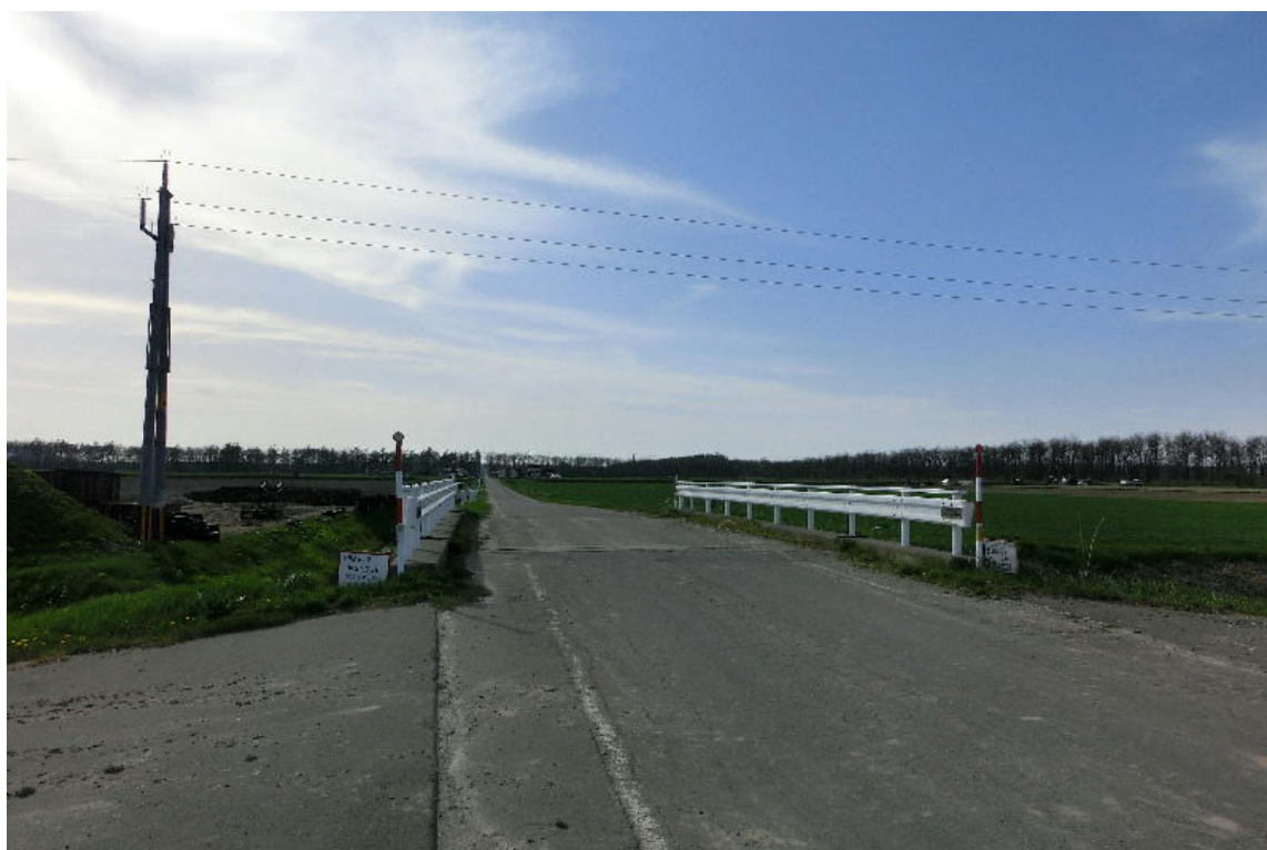
* 道道の8号道路標識側から見た橋の正面
