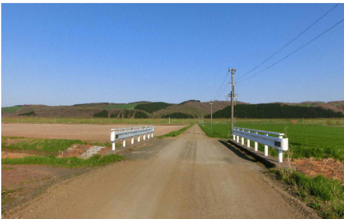
* 6号道路標識側から見た橋の正面
