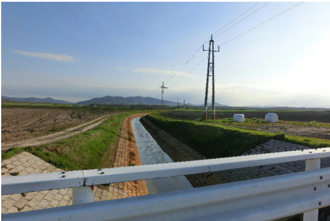
* 橋の上から南側（6号道路側）を見て
