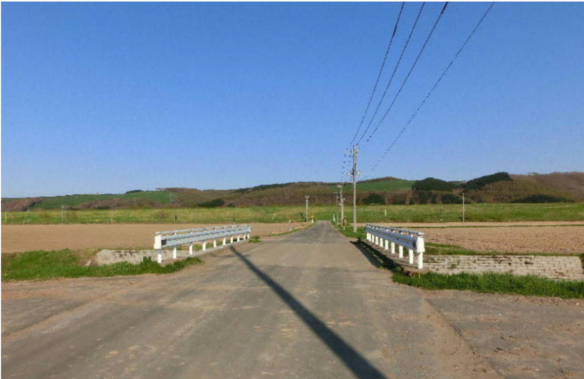
* 基線側から橋の正面を見て：奥が道道5号線の標識
