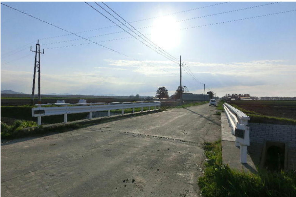
* 道道、5号道路側から見た橋の正面
