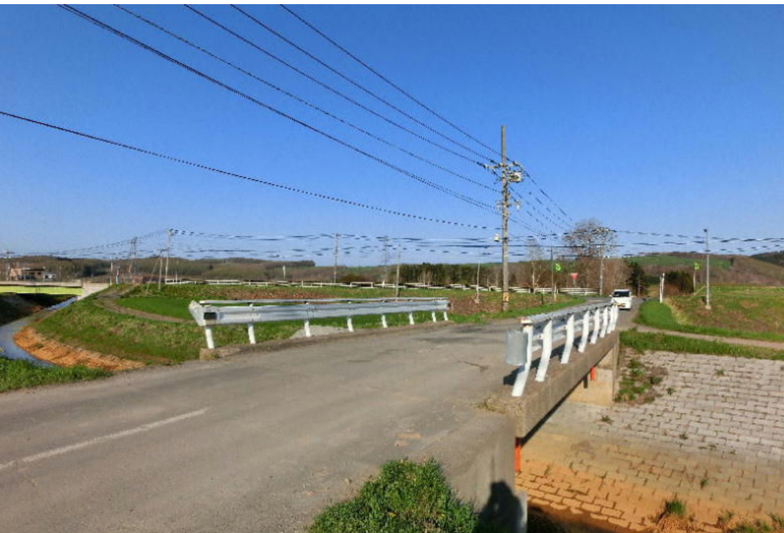
* 基線側から橋の正面を見て（左に土佐橋）
