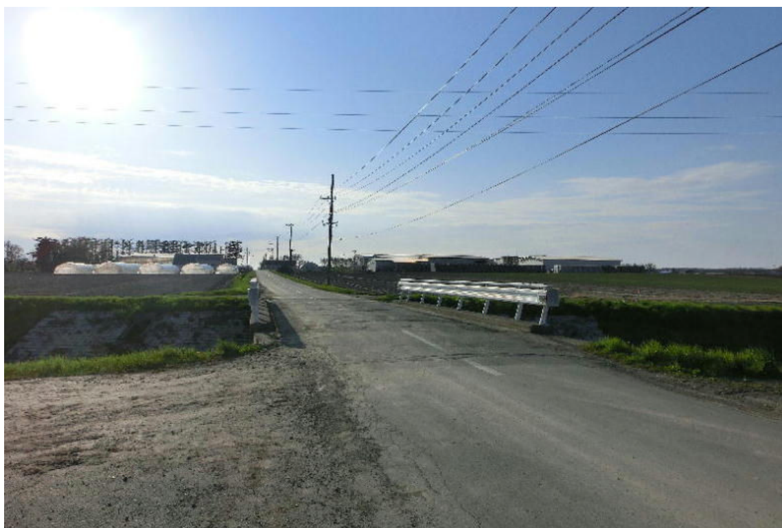
* 道道、4号道路側から見た橋の正面
