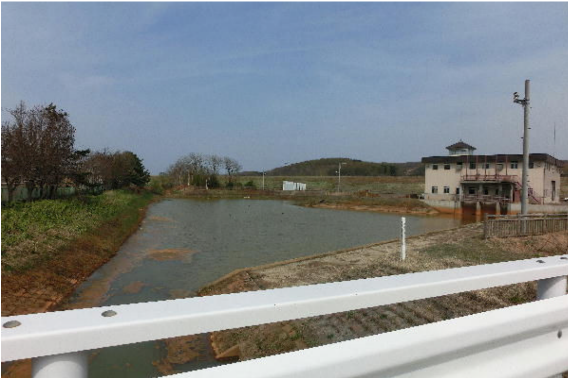
* 橋の上から右手に排水機場、排水路の先には常呂川に 続く樋門があります。
