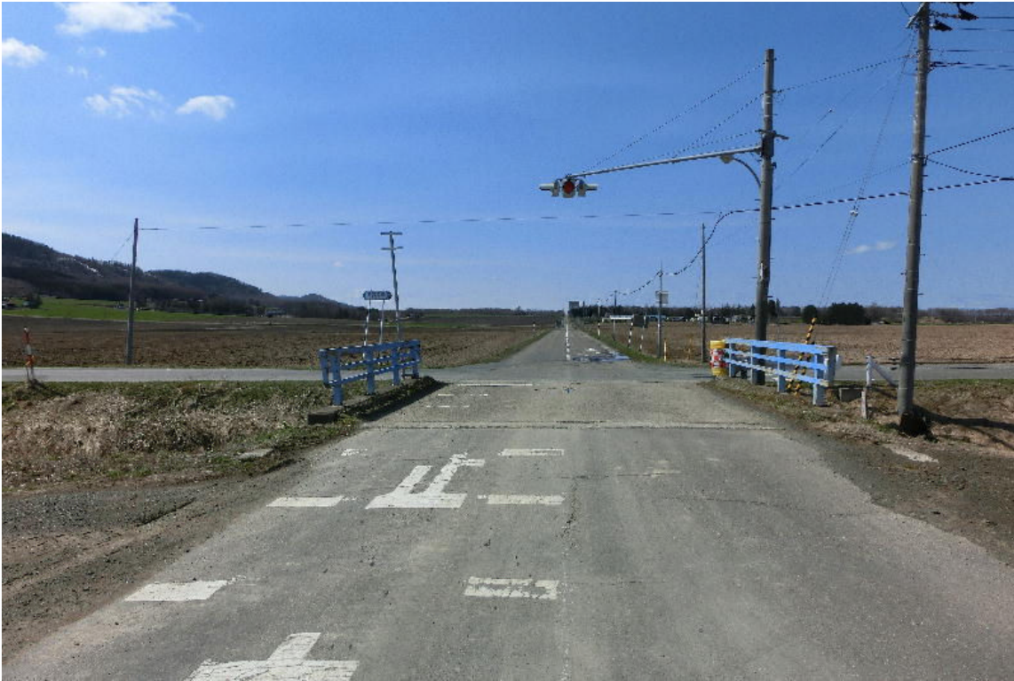
* 道道北見・常呂線側から見た橋の正面：横切っている道路は基線
