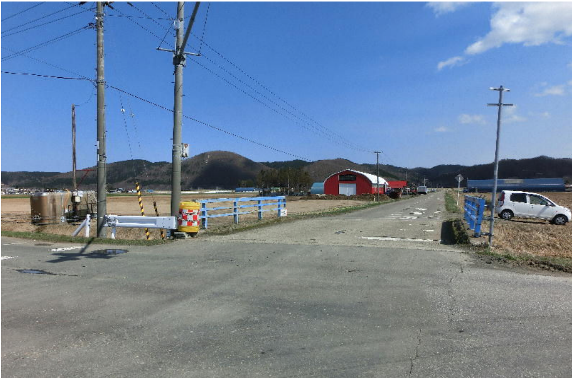
* 基線から見た橋の正面：奥に道道北見・常呂線側
