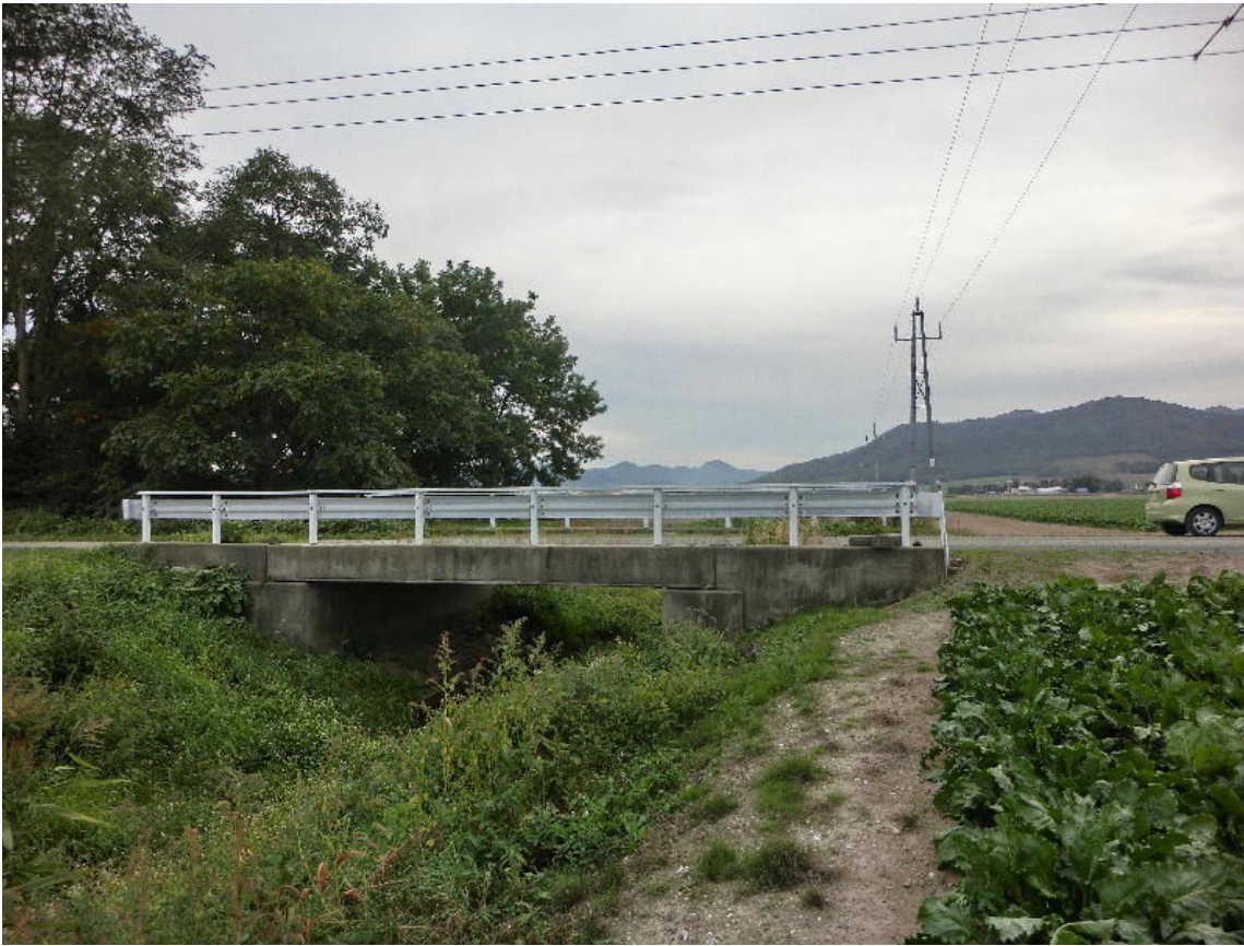
* 常呂側から橋を横に見て（奥にイワケシュ山）
