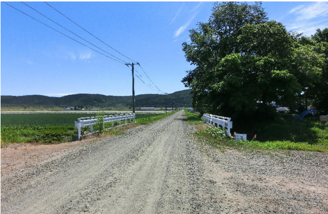
* 西 1 線側から橋を正面に見て
