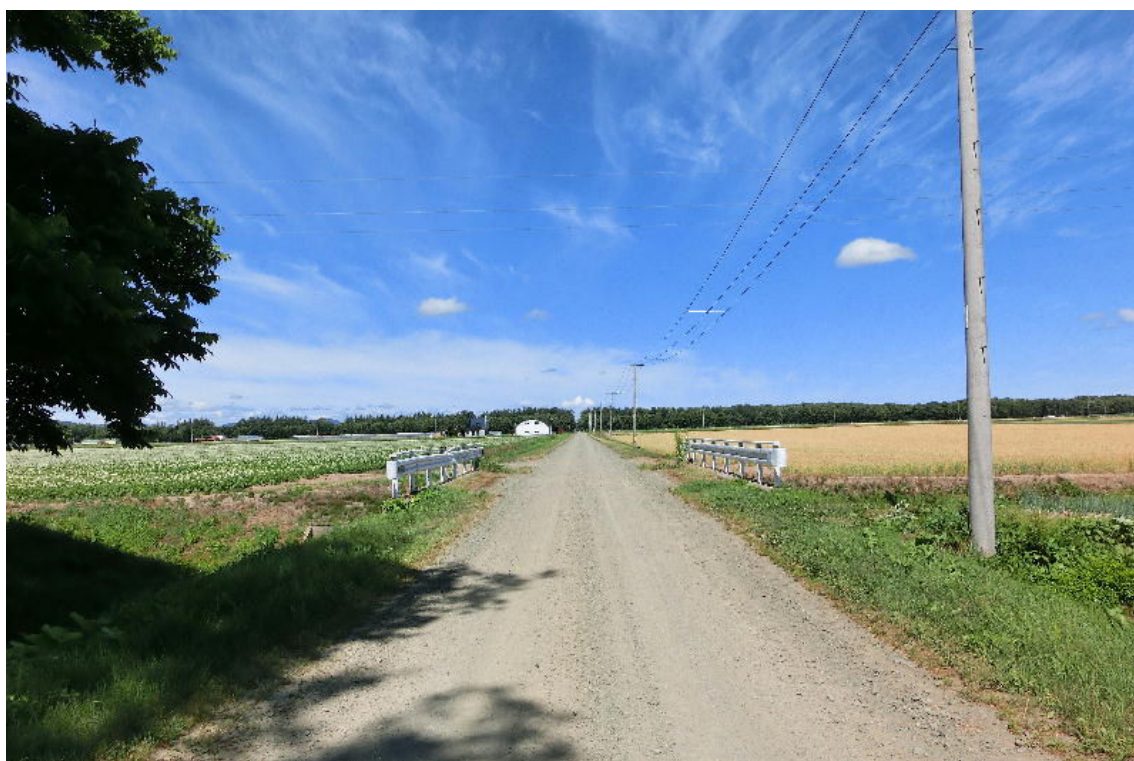
* 基線側から見た橋の正面
