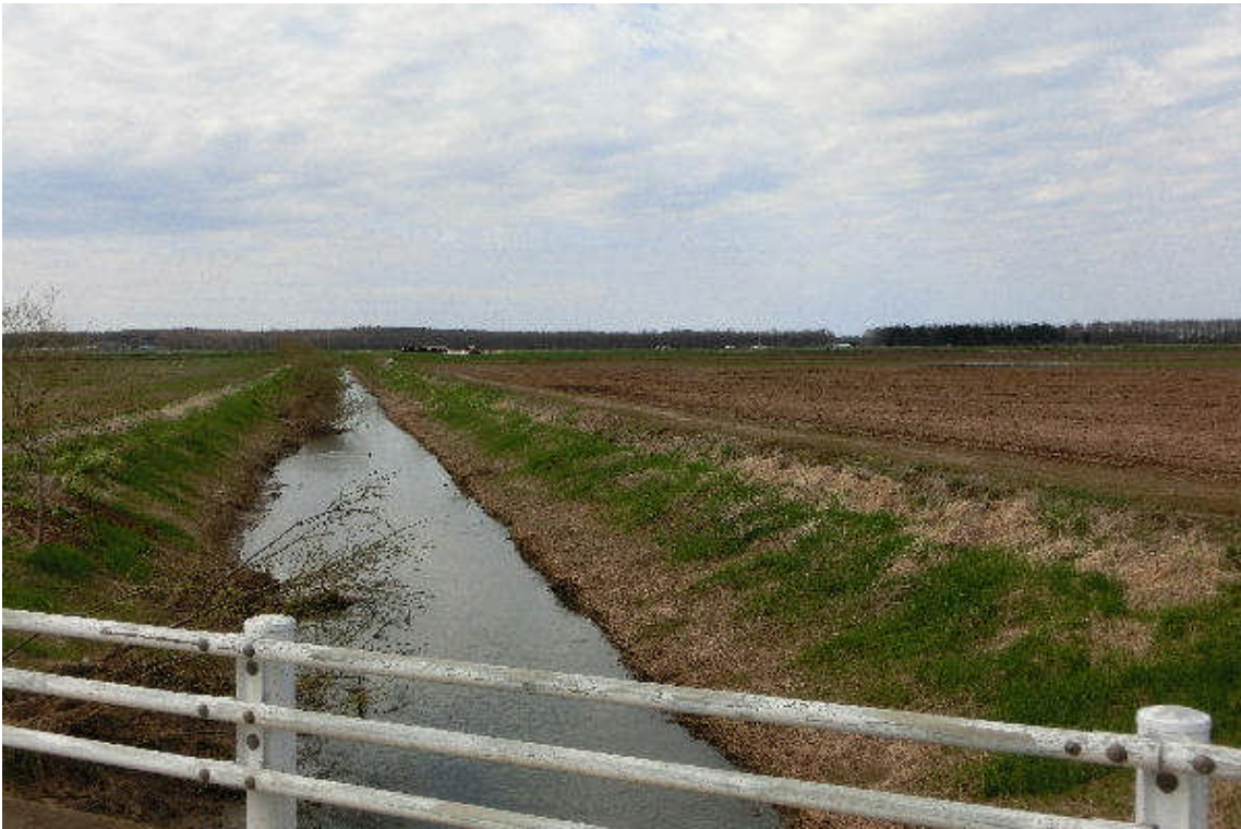
* 橋の上から下流（12号：常呂方面）を見て
