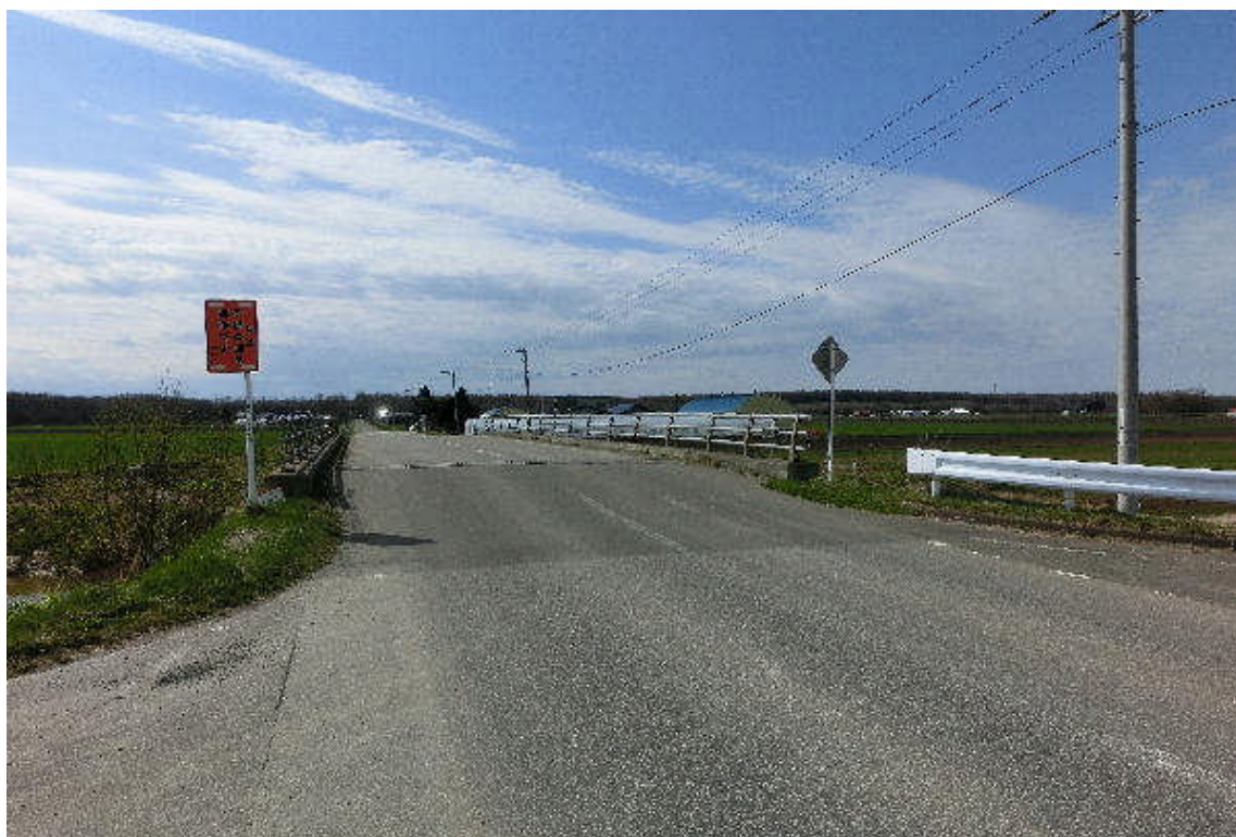
* 西 4 線側から見た橋の正面（奥は岐阜方面）
