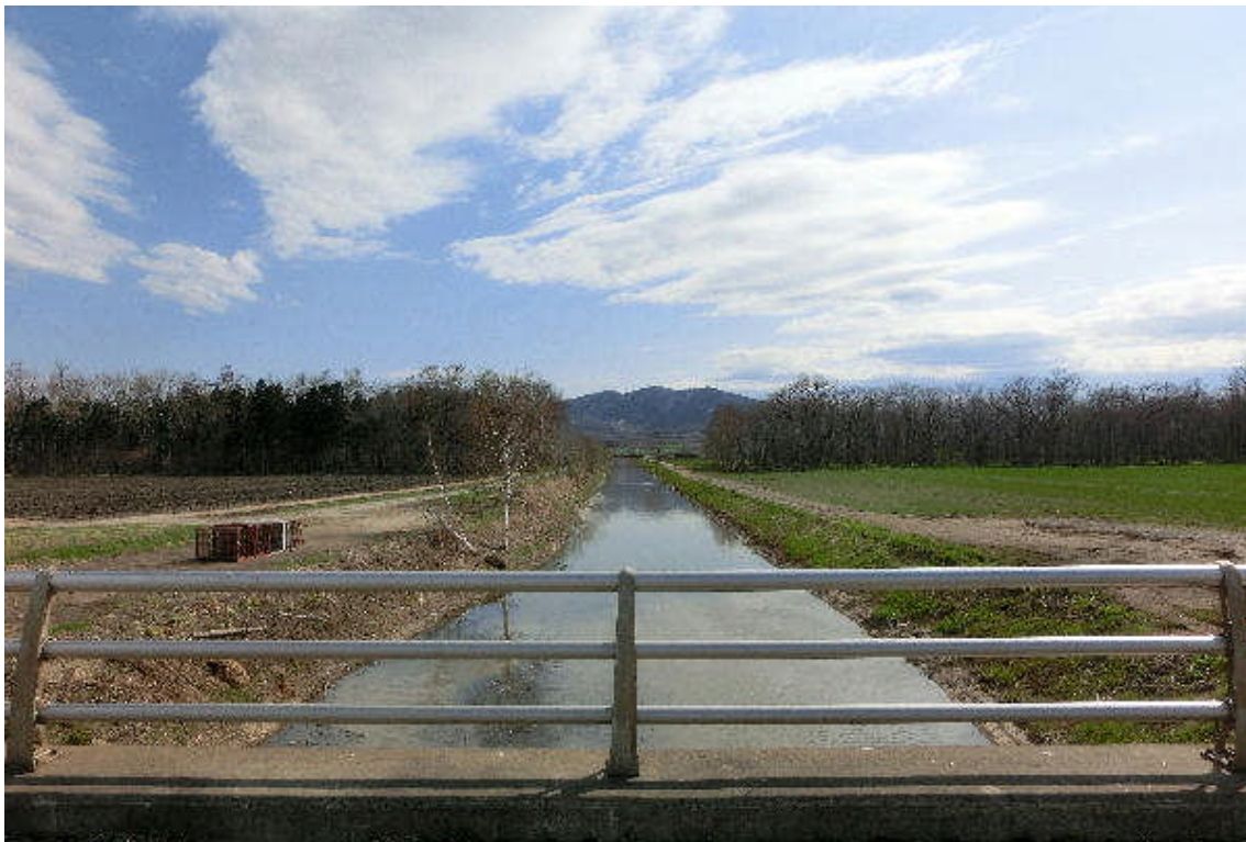
* 橋の上から上流（12号：イワケシュ山方面）を見て
