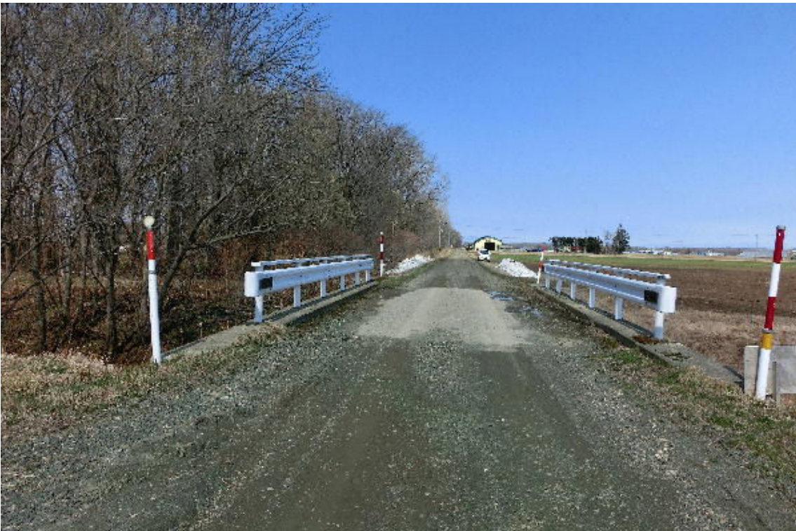
* 14号：イワケシュ山側から見た橋の正面
