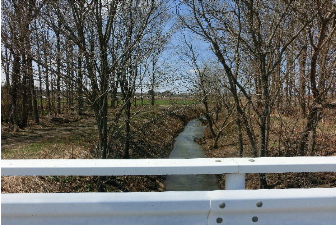
* 橋の上から下流を見て：西3線側
