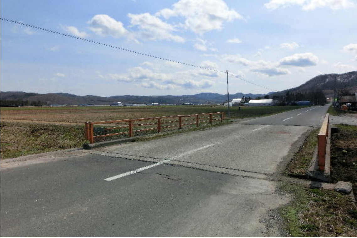
* 1 3 号側から見た橋の正面 : 奥にイワケシュ山
