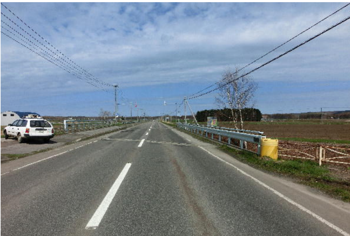
* 対岸から見た橋の正面
