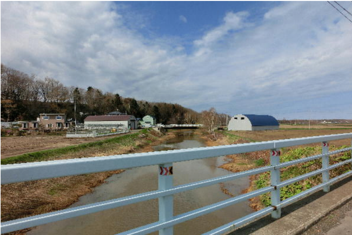
* 橋の上から下流を見て：奥に見える橋は5号橋
