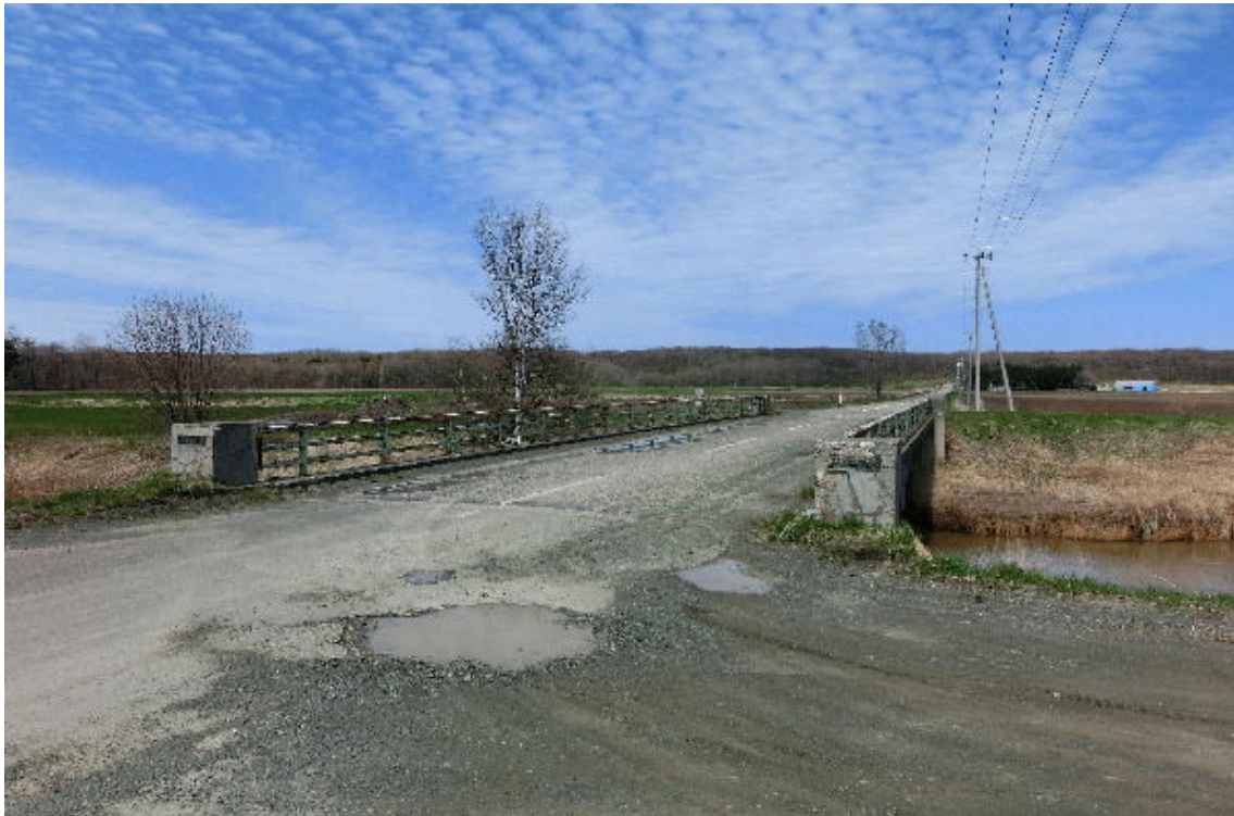
* 対岸の岐阜内陸部から見た橋の正面
