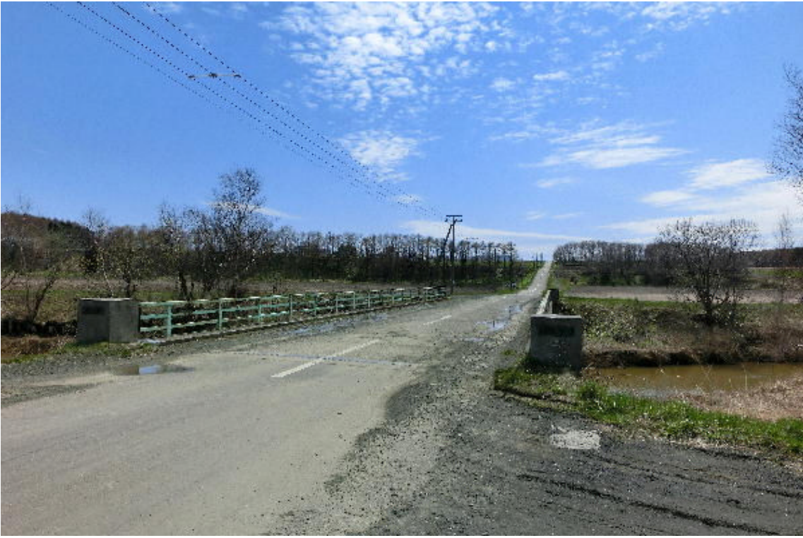
* 道道サロマ湖公園線側から見た橋の正面
