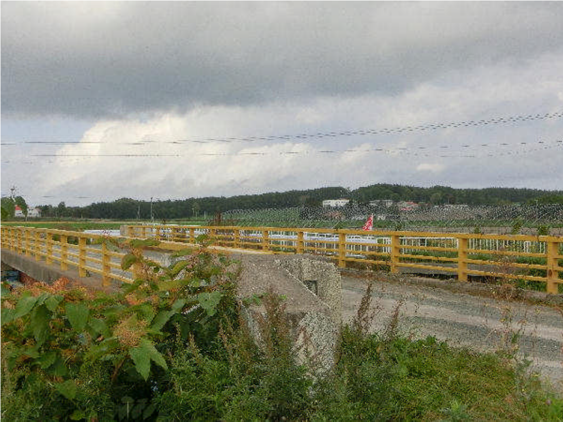
* 西4線側から斜め（下流側）に橋を見て
