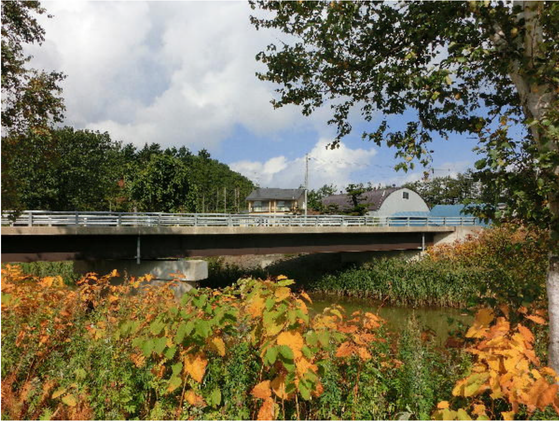
* 橋の下流側から橋を斜めに見て
