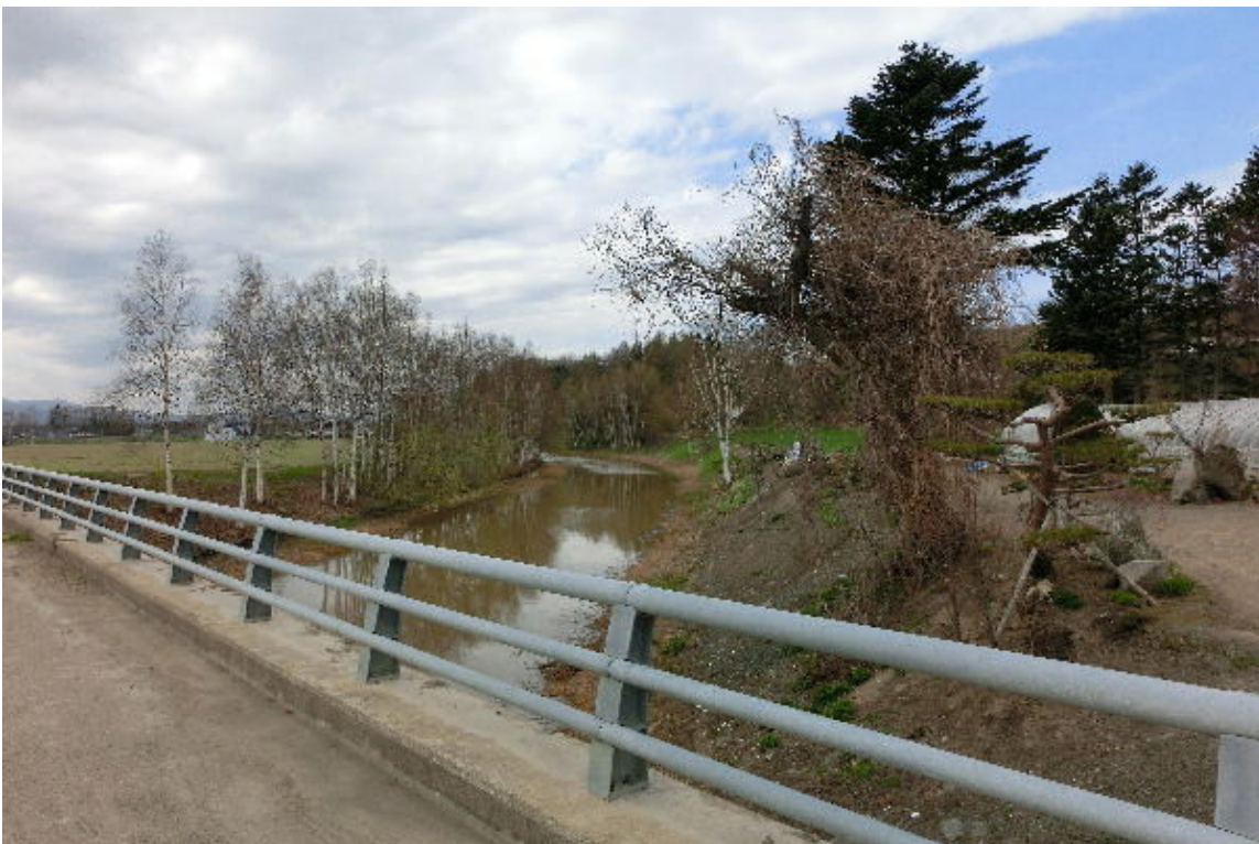
* 橋の上から下流を見て
