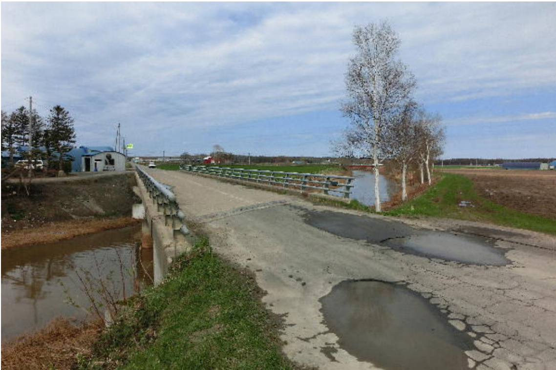
* 西4線5号側から見た橋の正面：右手が上流
