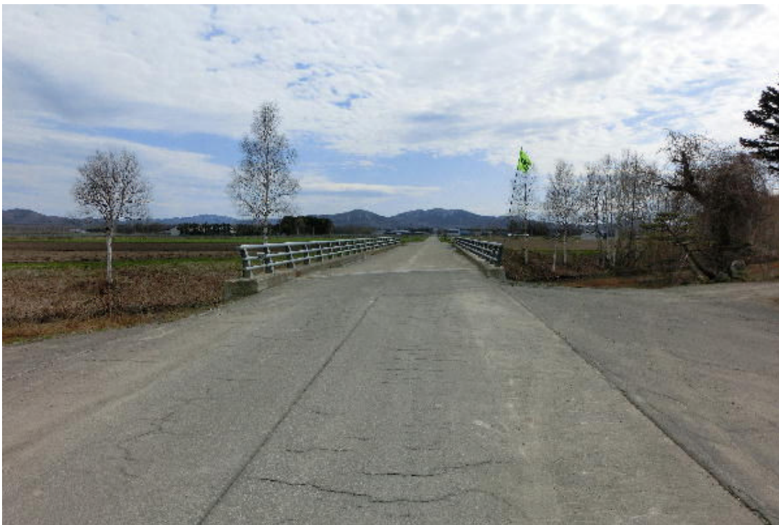
* 西4線4号側から見た橋の正面：右手に民家
