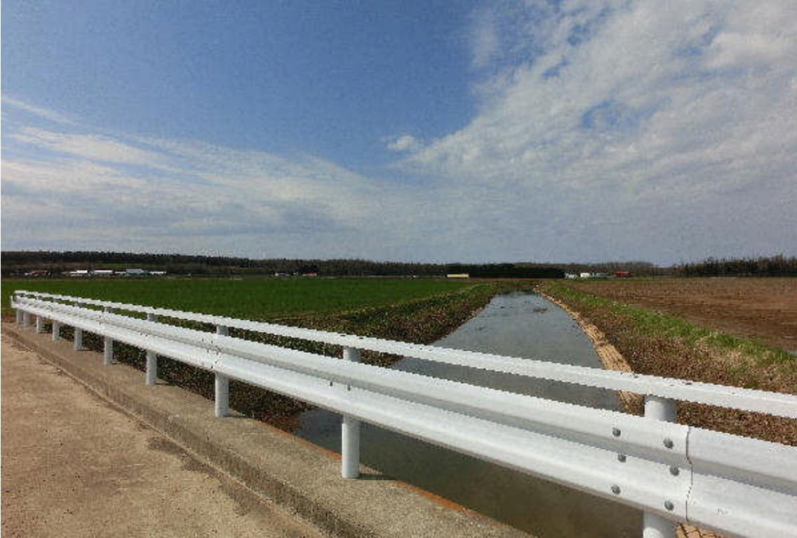
* 橋の上から下流（8号、常呂方面）を見て
