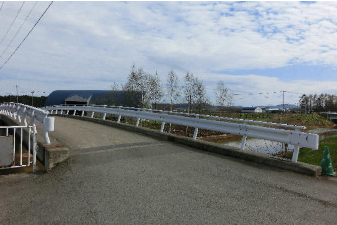
* 小松水産側から見た橋の正面
