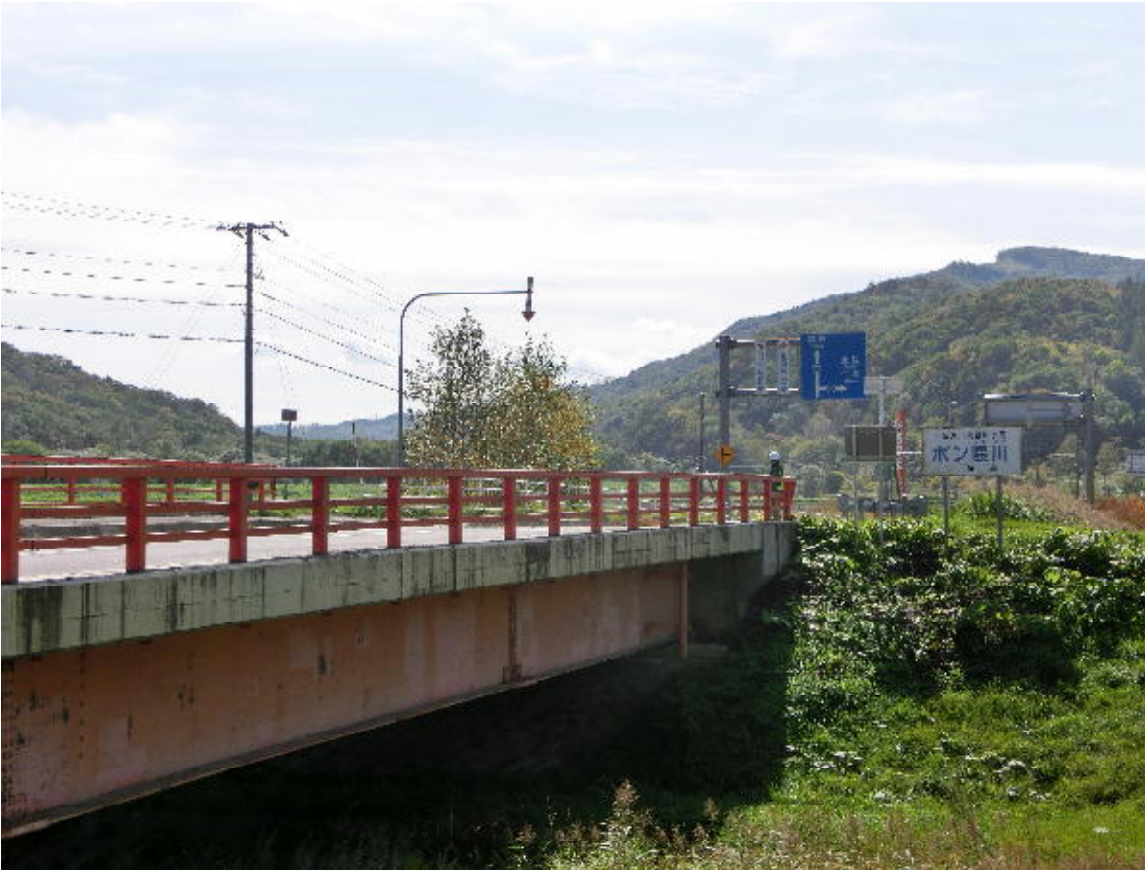
* 日吉側、ポン隈川の上流側から橋を斜めに見て
