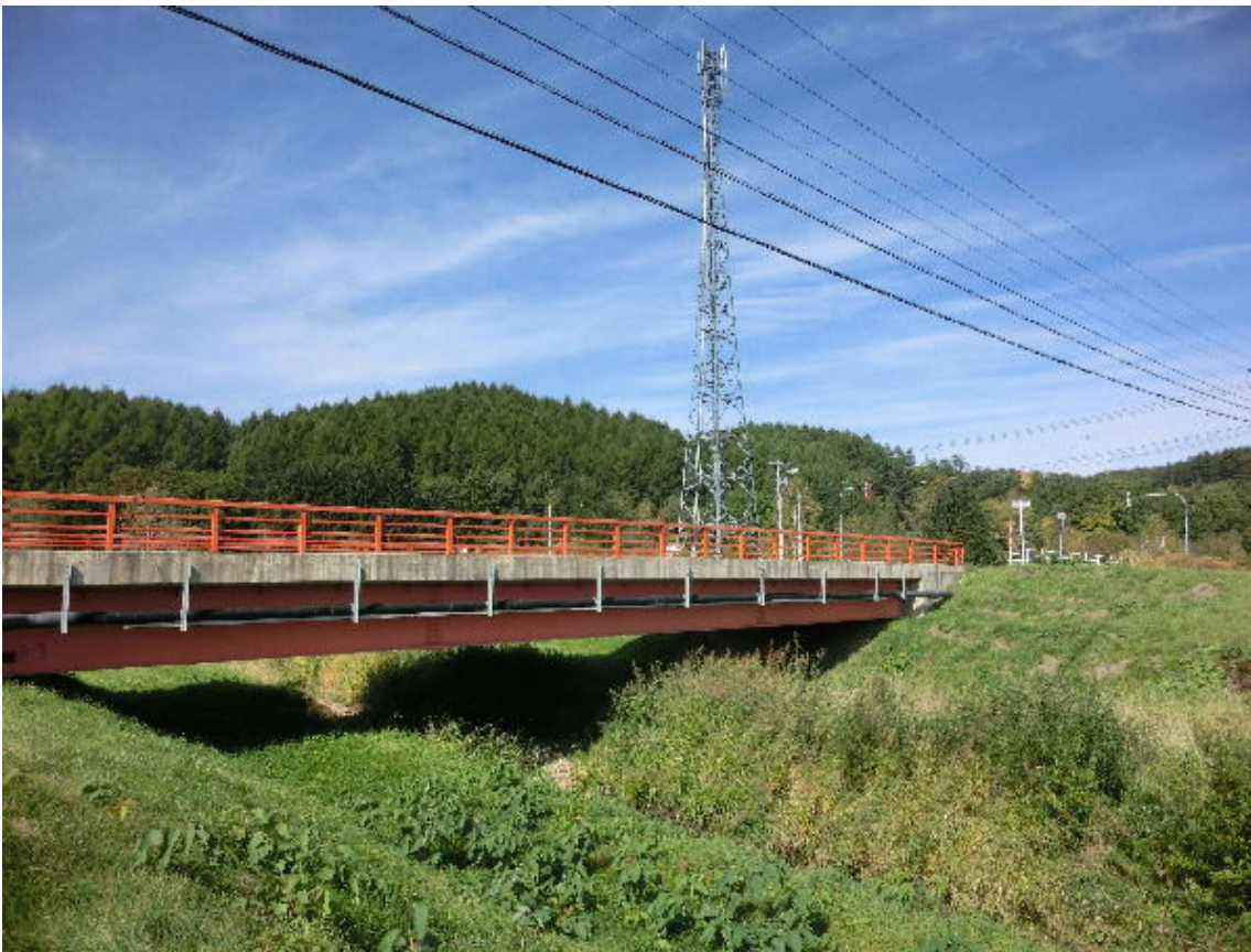
* 交差点側、川の上流側から橋を斜めに見て
