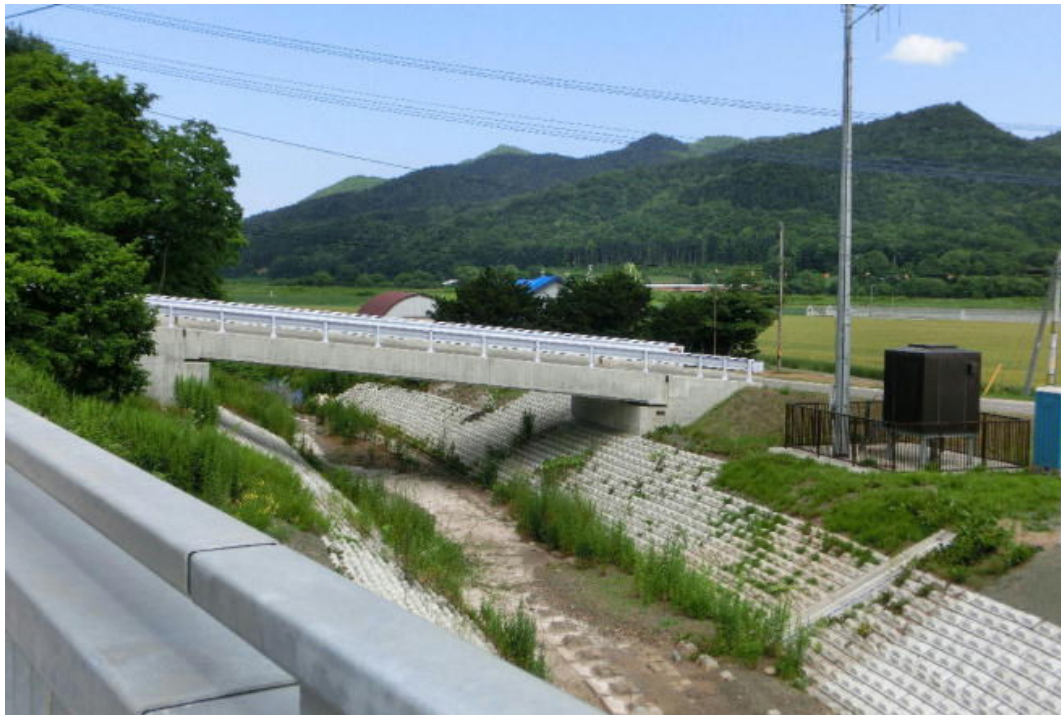
* 令和2年8月完成の日吉橋から日吉第1号橋を見て 下を流れているのは日吉川
