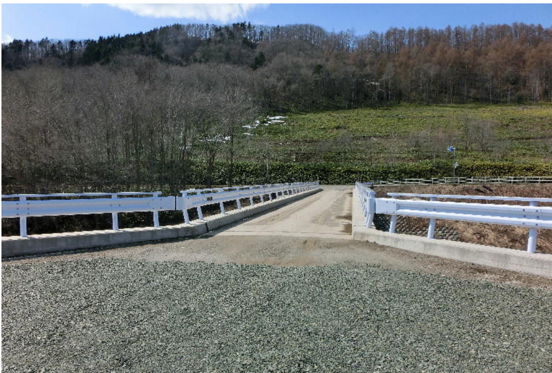
* 対岸から見た橋の正面：奥に道道
