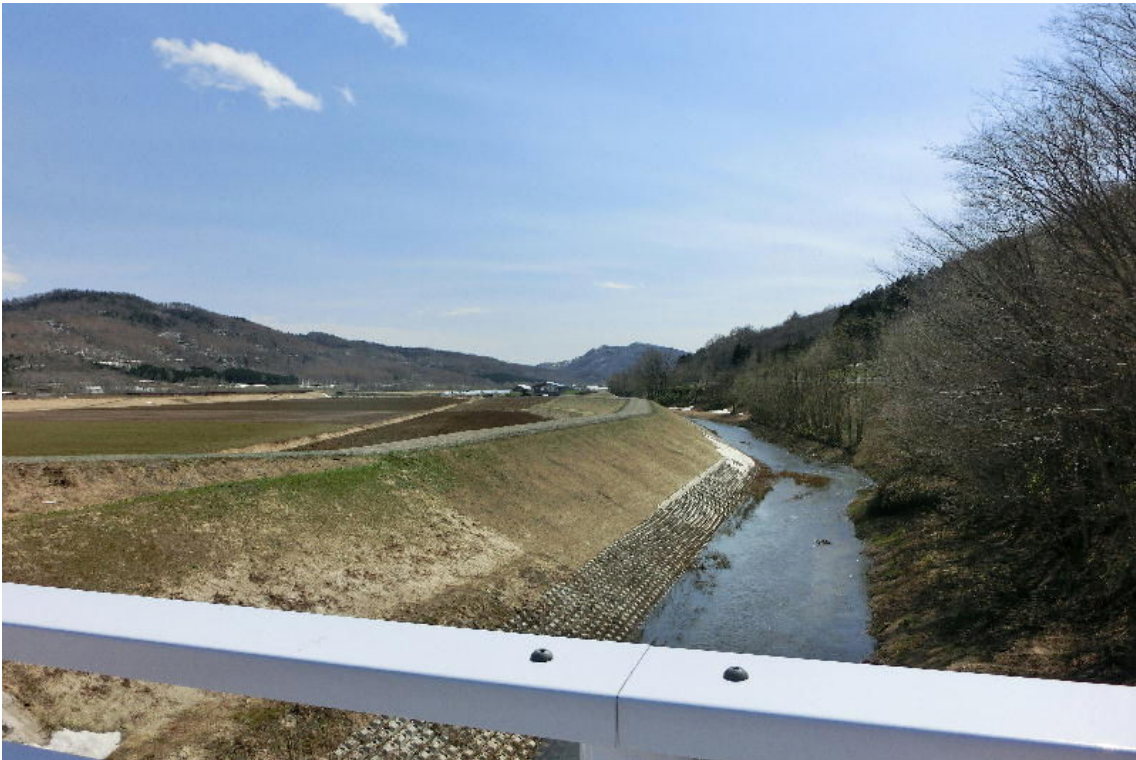
* 橋の上から上流を見て：日吉市街方面
