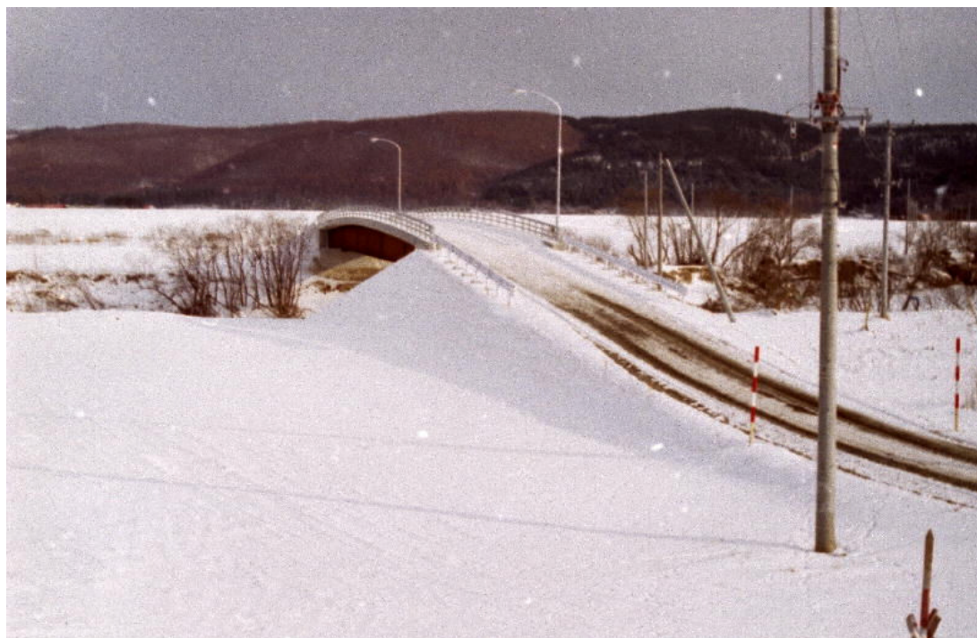
* 平成5年2月17日直後の共立橋
