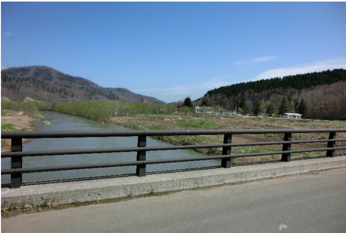
橋の上から下流を見て（中央奥に旧福山小が見える）
