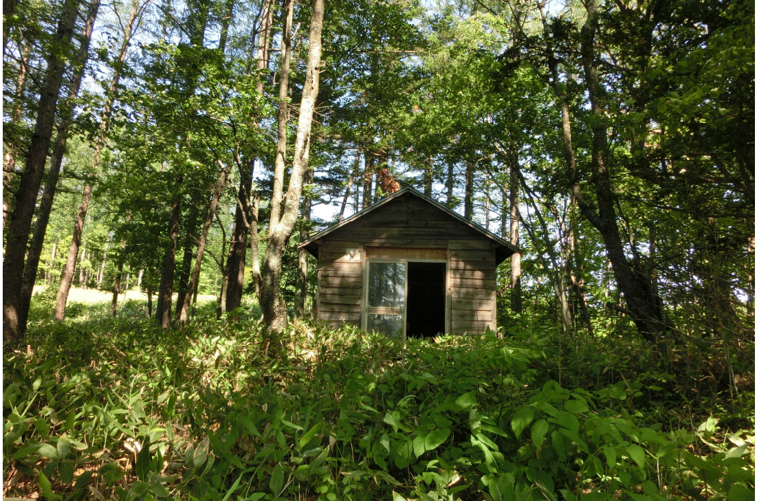
正面(玄関)は南側を向き、斜面を見下ろす
