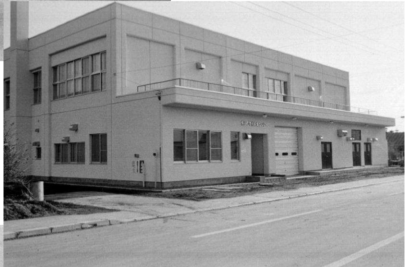
＊下：完成した給食センター 正面（西側）
