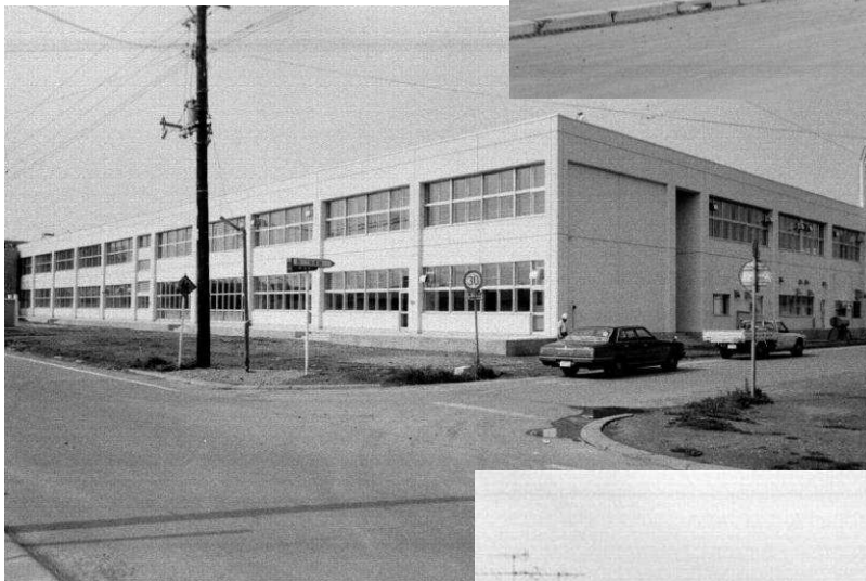
＊下：完成した小学校校舎 （南側）
