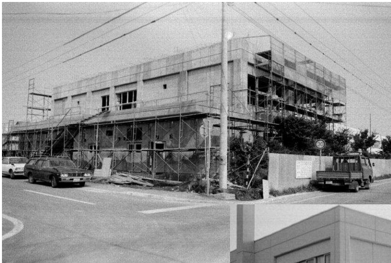
＊左：建設工事中の学校給食センター （1階が給食センターで 2階がランチルーム）
