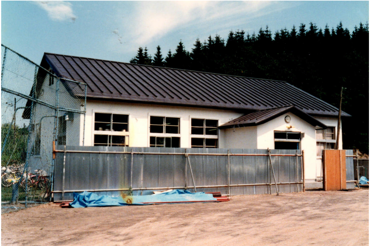
*上：8月 昭和33年建設の体育館のペンキ塗り（新たに整備する校舎と同色）
