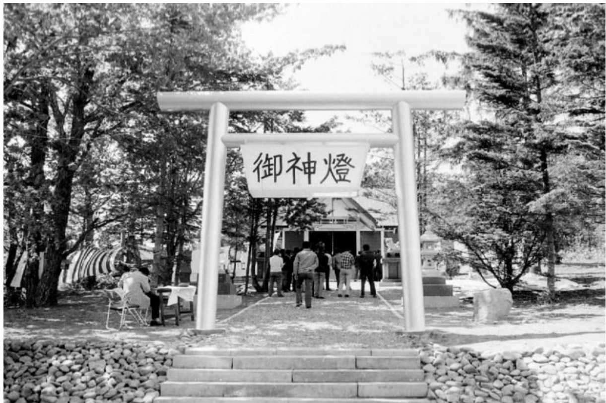
完成した岐阜神社の正面：鳥居・社殿
