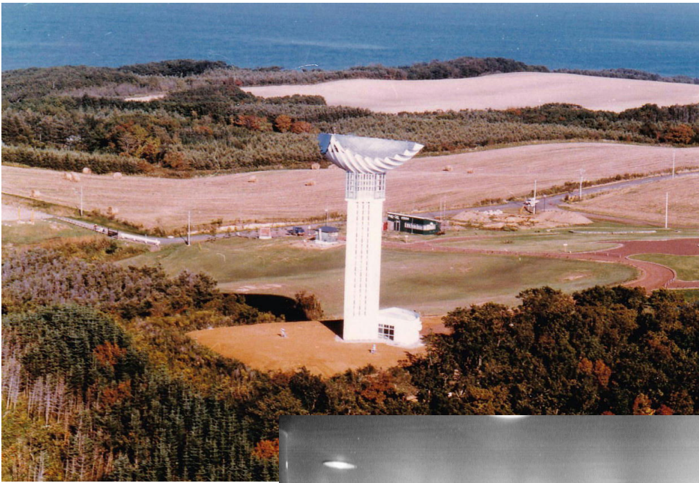
左： 西側上空から 見た展望塔
