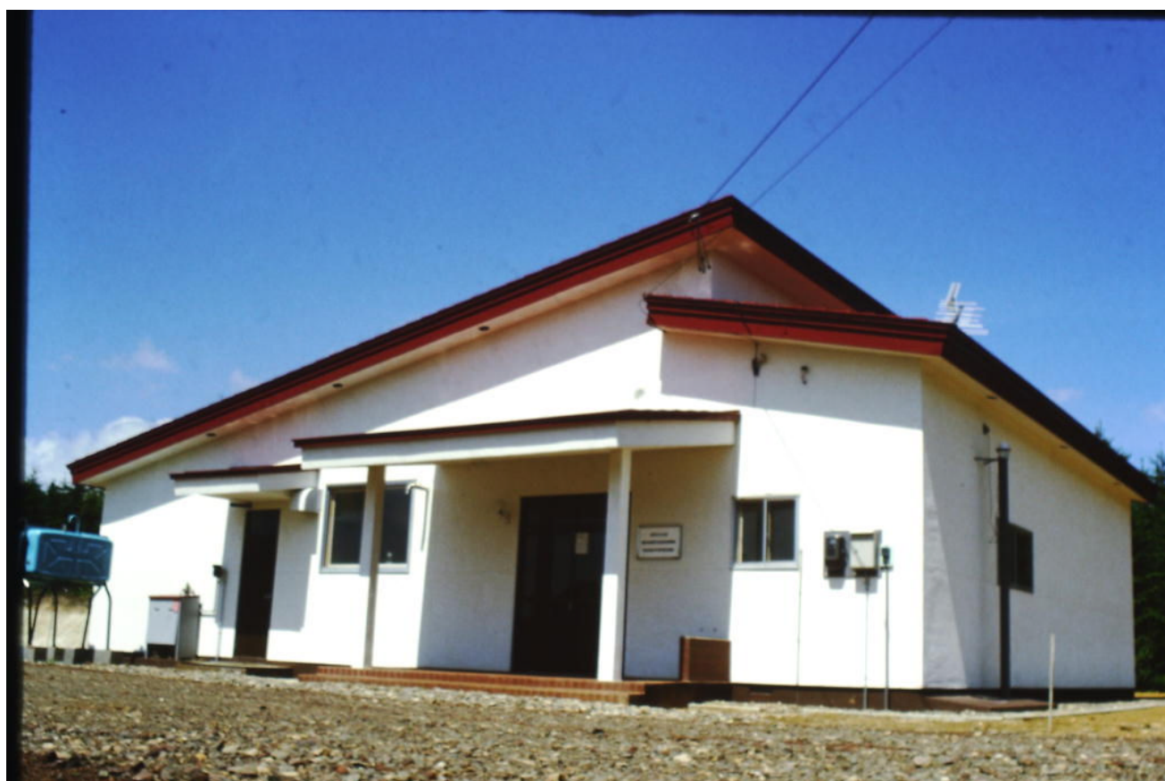
* 正面から見た東浜地区多目的集会施設
