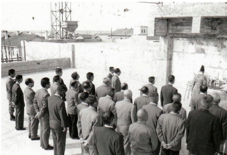
*昭和41年9月6日 常呂町役場庁舎建設 工事上棟式：屋上
