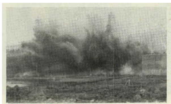
コンクリート壁の爆破
