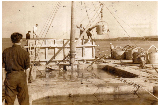
*下2枚：常呂漁港工事中の写真
