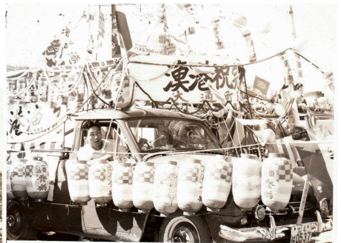
*上：漁港完成の喜びがトラックの飾り 付けに表現されています
