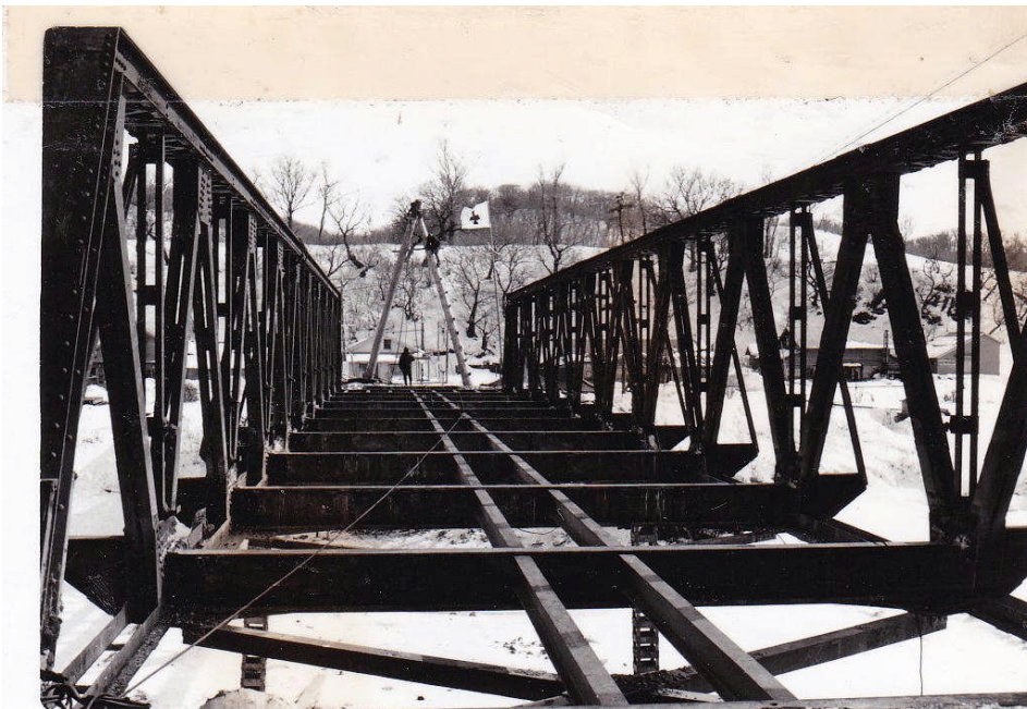
*解体作業中の 旧常呂橋
