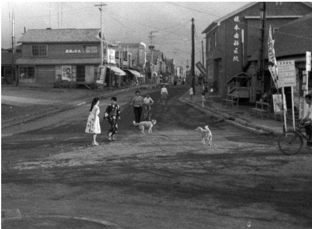
間もなく舗装工事が始まる頃の駅前交差点
