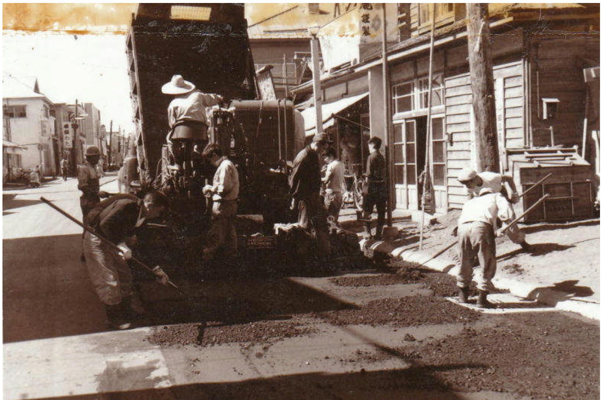
下：本通りの舗装工事
